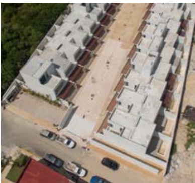
Trabajos de Terracería
